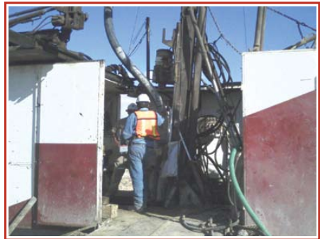
Recursos Excellon, Mina Platosa, México Se realizaron operaciones de perforación profunda y de inyección de cemento de alto volumen para sellar formaciones rocosas saturadas de agua y recuperar con éxito una mina de plata inundada.
