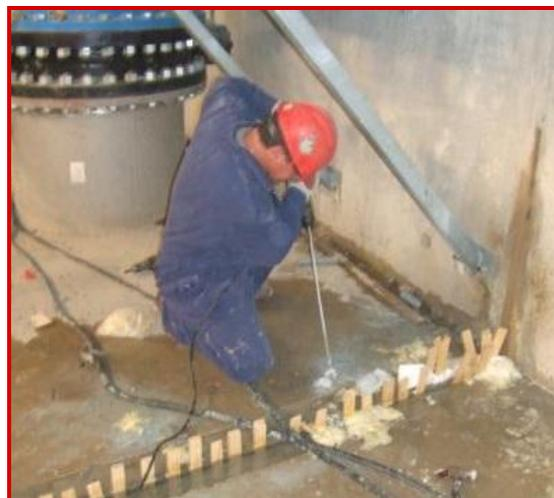
Les fissures qui fuient sont réparées en permanence à l'aide de résine 'FLEXIBLE RESIN'.
