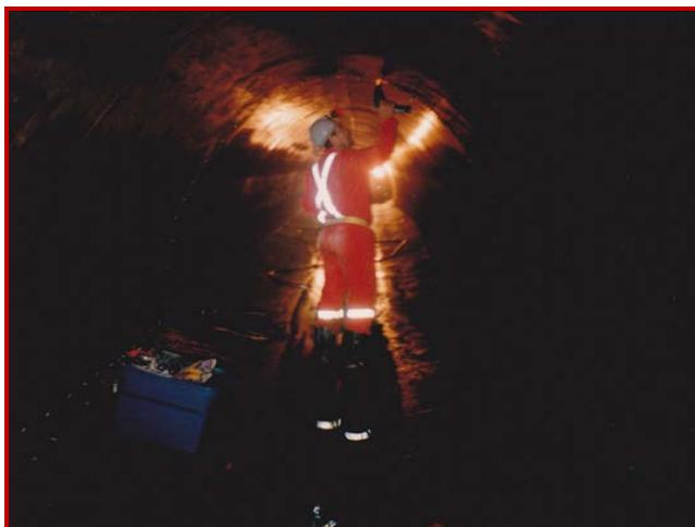
Les fissures et les joints de construction dans les structures d'eau potable sont scellés de façon permanente à l'aide de résine 'FLEXIBLE RESIN'.
