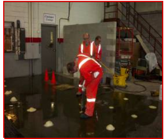
'RIGID GROUT' est une solution abordable pour remplir les vides sous les dalles de béton.
