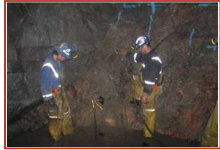
Rio Tinto, Mina de Diamante Diavik, Canadá Antes de las operaciones de excavación de minas subterráneas, se utilizaron métodos de inyección de cemento para rellenar fracturas saturadas de agua y reducir el potencial de infiltraciones de agua subterránea de alto volumen.
