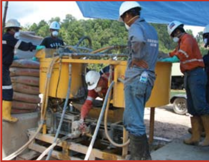
Minería Newcrest, Proyecto Kencana K2, Indonesia Se utilizaron lechadas de cemento microfino para mejorar las condiciones del suelo fracturado y saturado de agua antes de la construcción del pozo de ventilación, utilizando métodos de perforación en remonta.
