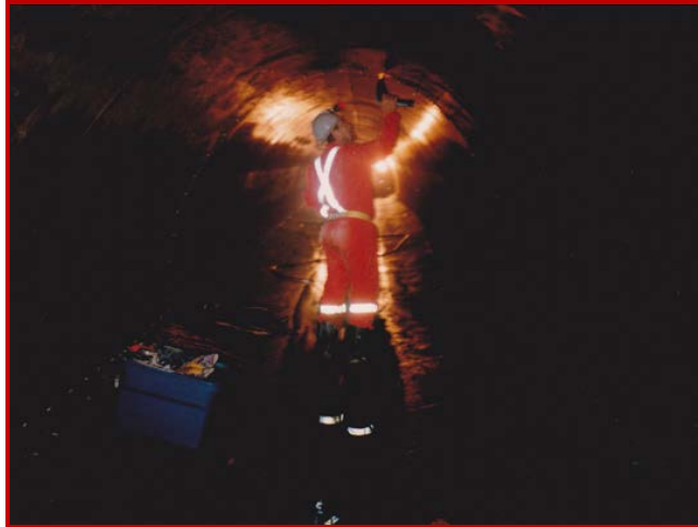
Les fissures et les joints de construction dans les structures d'eau potable sont scellés de façon permanente à l'aide de la résine 'MME FLEXIBLE RESIN'.
