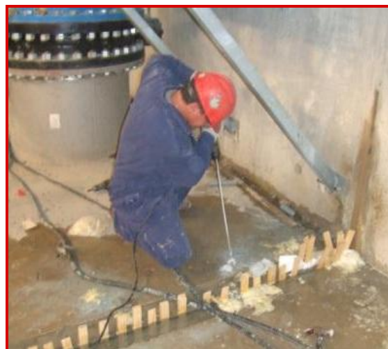
Les fissures qui fuient sont réparées en permanence à l'aide de la résine 'MME FLEXIBLE RESIN'.
