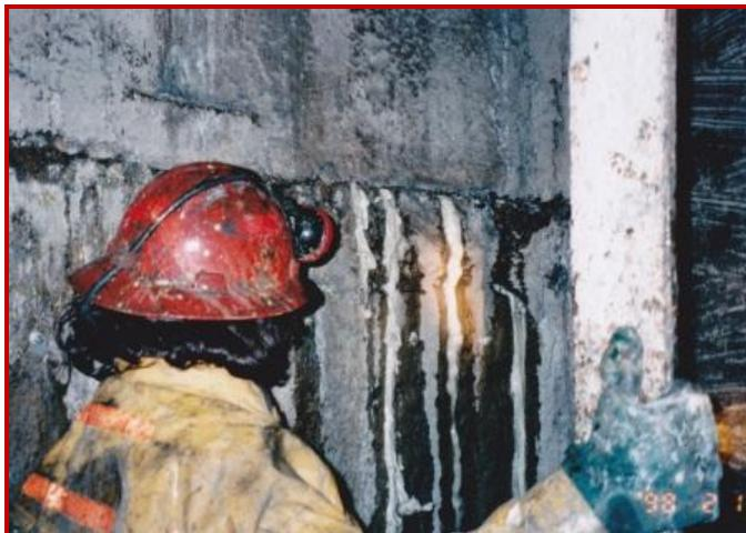
La résine 'MME UNIVERSAL RESIN' est utilisée pour arrêter les entrées d'eau à travers les joints de construction en béton qui fuient dans un puits de mine souterrain.
