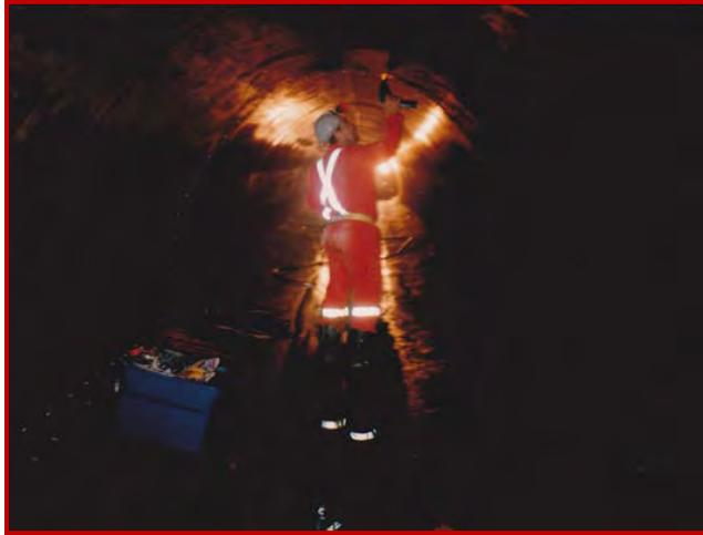
Les fissures et les joints de construction dans les structures d'eau potable sont scellés de façon permanente à l'aide de la résine 'MME FLEXIBLE RESIN'.
