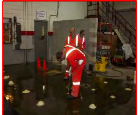
'RIGID GROUT' est une solution rentable pour remplir les vides sous les dalles de béton.
