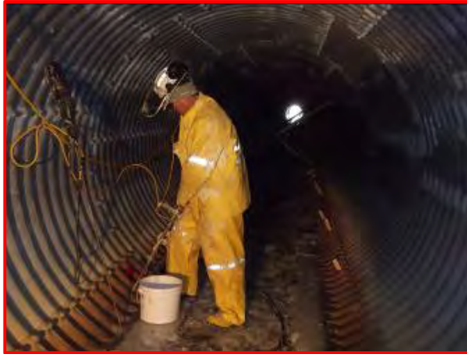
'RIGID GROUT' est utilisé pour combler les vides dans les ponceaux sous une piste d'aéroport. Des réparations ont été nécessaires pour empêcher le tassement du sol.
