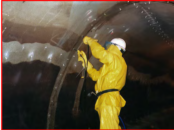
Les fissures et les joints de construction dans les structures en béton sont convenablement nettoyés avec le 'CRACK FLUSHING AGENT' avant l'injection de polyuréthane
