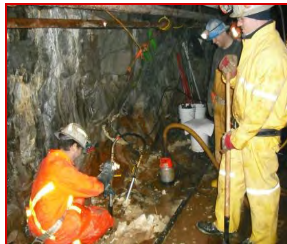
La résine 'MME UNIVERSAL RESIN' est utilisée pour arrêter les problèmes d'entrée d'eau pour les entrepreneurs en construction de tunnels.
