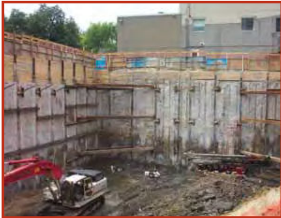
Excavation profonde, coulis de ciment, Toronto, Ontario Le coulis de ciment est couramment utilisé pour combler les vides et sceller les infiltrations d'eau dans les excavations étayées.
