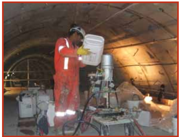
Construction de tunnels, coulis chimique, Edmonton, Alberta Le coulis chimique est utilisé pour stabiliser le sol, couper le débit d'eau actif et sceller les joints qui fuient dans diverses formes de construction de tunnels.
